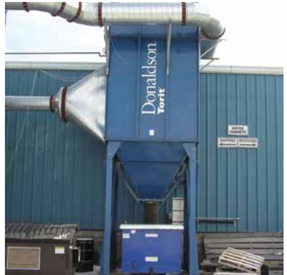
54MBTH8 - Gabinete en Corte, Moldeado y Lijado de Madera
